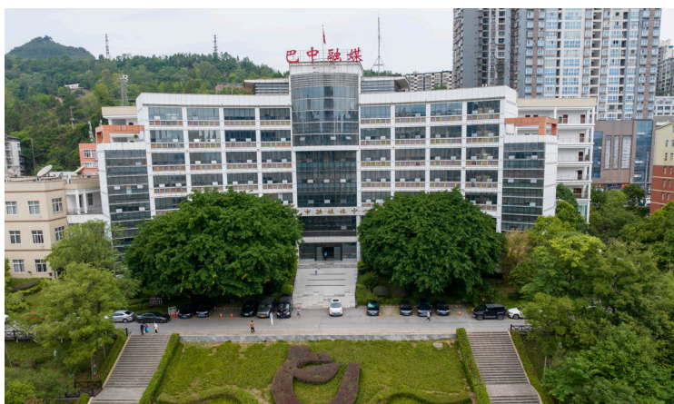
巴中市融媒体中心办公大楼。
